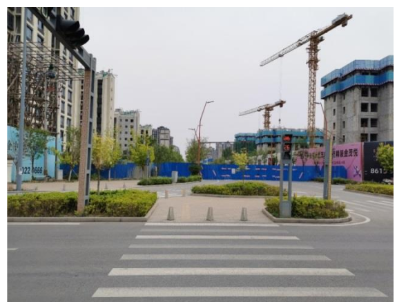
【図表 19】 北京市内にある工事現場
